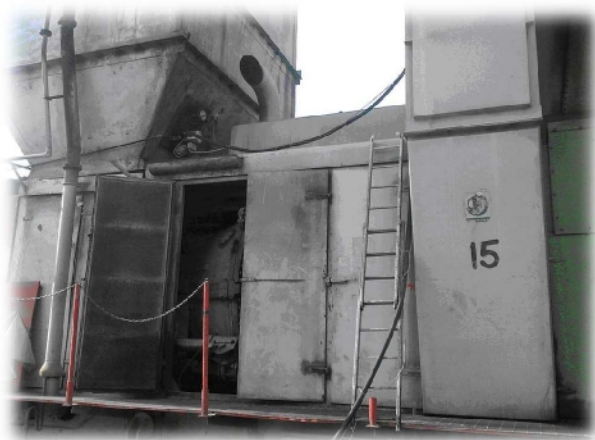
شکل (۶): محل نصب پروب نمونه‌برداری، سنسور دما و فشار بر روی دودکش واحد ۱۵ نیروگاه ری
